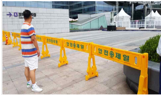
안전펜스 설치로 작업 현장과 고객 동선 구분
