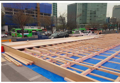
구조물 시공 간 바닥 보양
